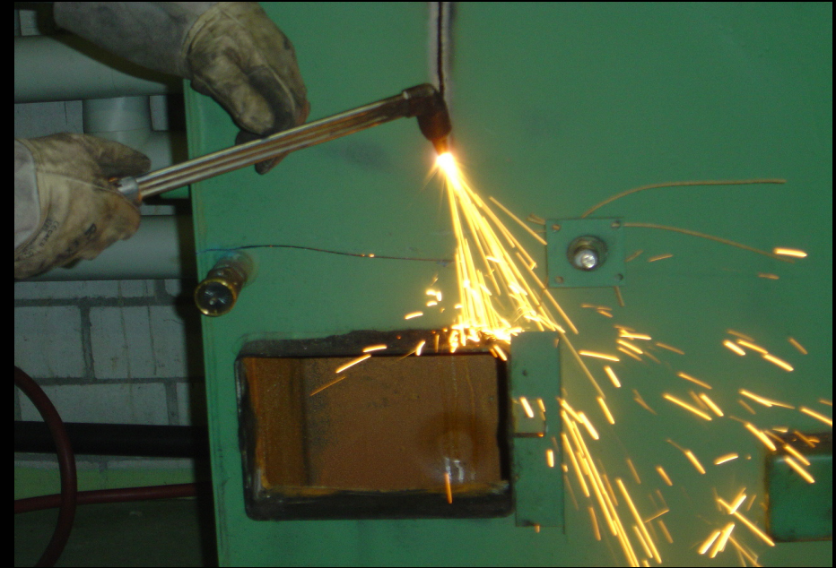
Zerlegen der Heizungsanlage
