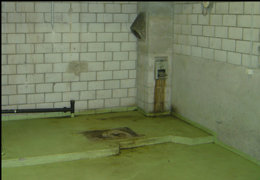
Arbeitsplatz nach erfolgter Demontage
